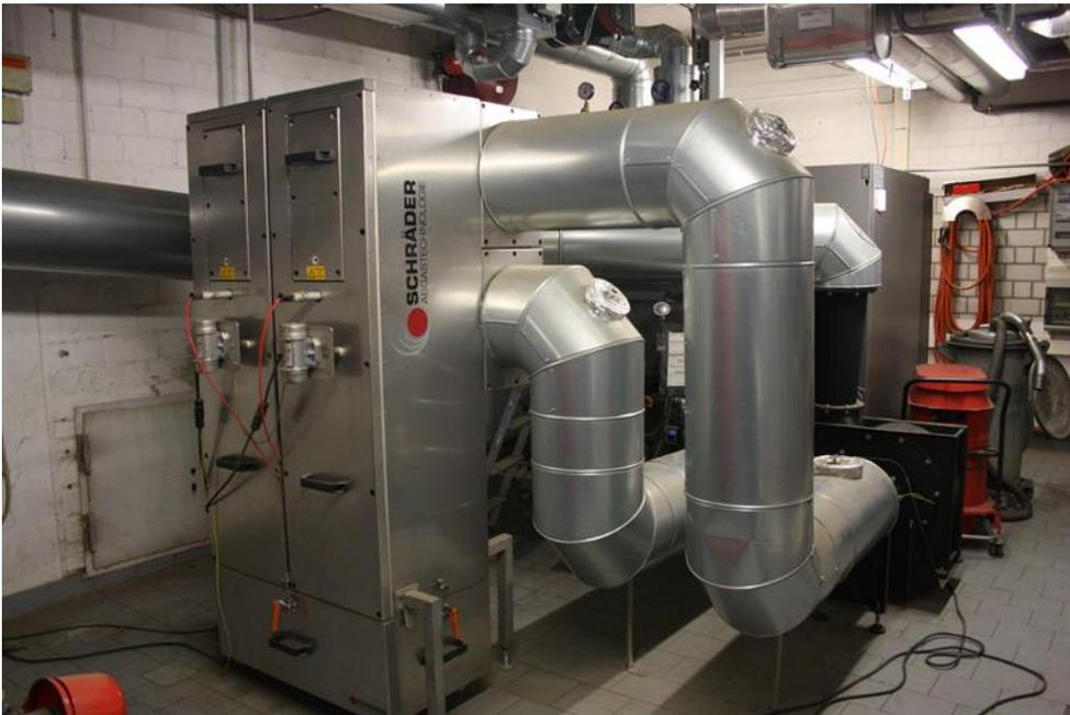
Abbildung 2: Hackschnitzelkessel mit Hochvoltabscheider für Feinstaub<sup>1</sup>
