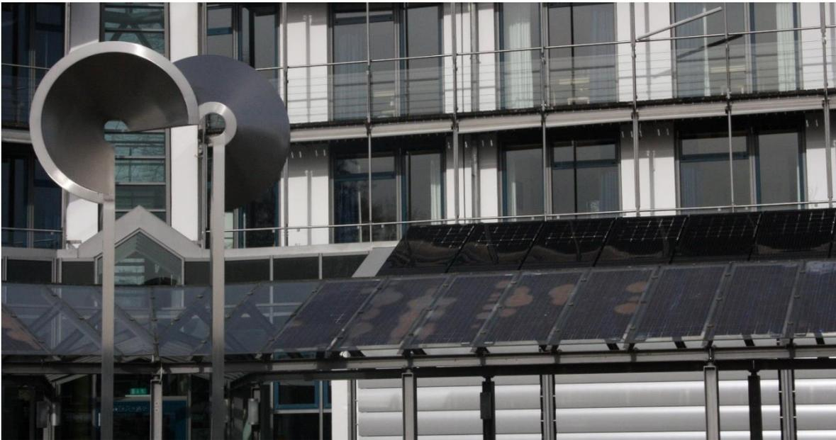
Abbildung 3: Die Photovoltaikmodule auf den Kolonnaden (vorne, außer Betrieb) und als Verschattungselemente (hinten, neu)
